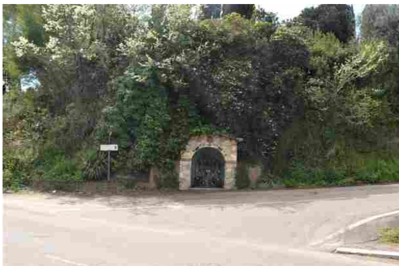
Panoramica del sito (rep. 3945 e 3956) in via Ardeatina, angolo via del Centro del Bivio.
